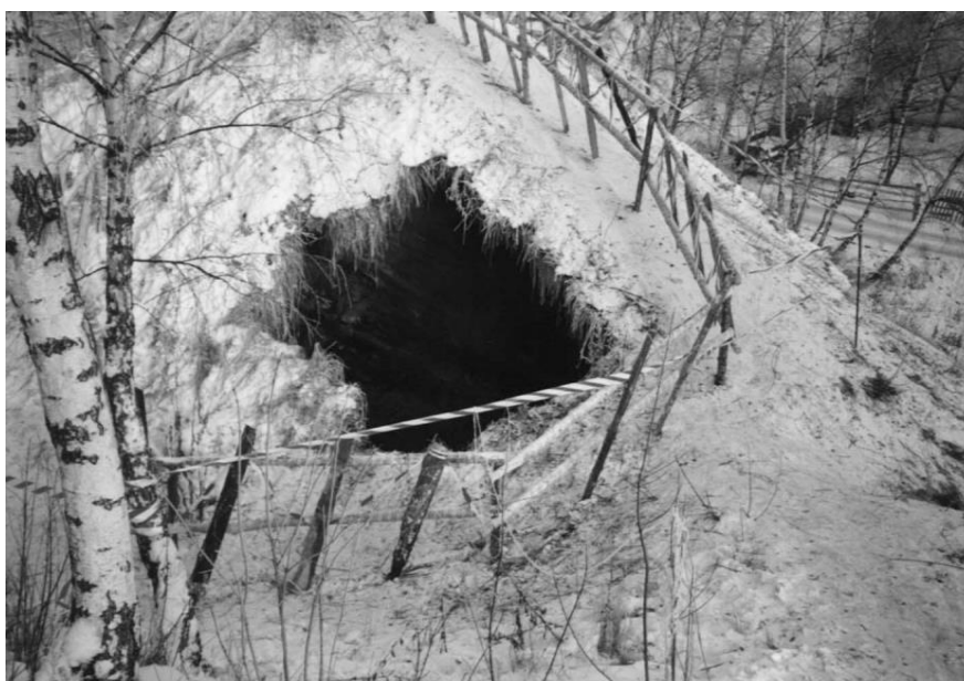
Rys 6.5 Nagłe odsłonięcie wylotu szybu Fig. 6.5 Sudden exoosure of shaft entry
