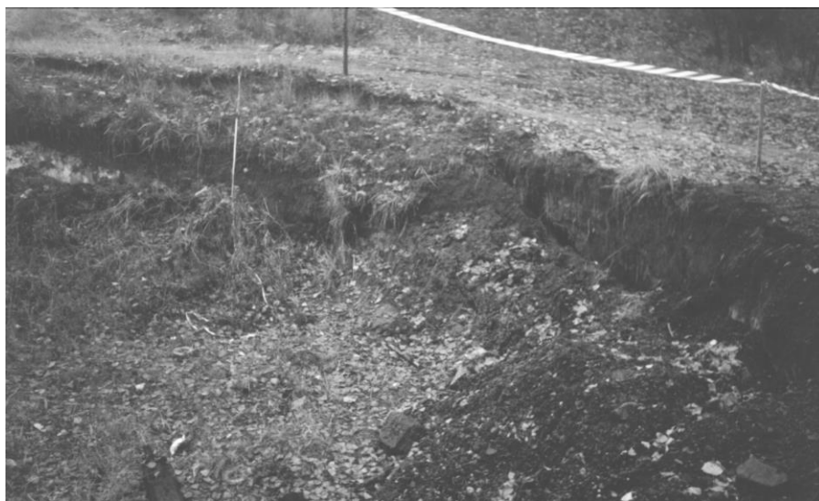
Rys 6.2 Zapadlisko nad płytką eksploatacją Fig. 6.2 Sinkhole over shallow exploitation
