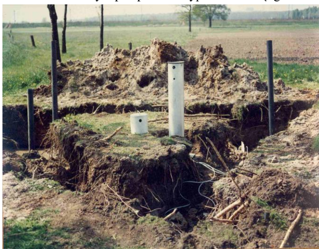
Rys. 3.2 Wykopy pod rozetę równoboczną przetworników Fig. 3.2 Excavations for instalation of equilateral rosette of strain transducer
