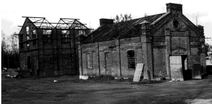
Rys. 2.2 Niedźwiedzia Góra – kopalnia Krystyna (stanowisko VII): resztki zabudowań dawnej kopalni węgla kamiennego Krystyna, z lewej strony z tyłu budynek nadszybia szybu wydobywczego Krystyna o głębokości 181 m. - tzw. szyb wodny
