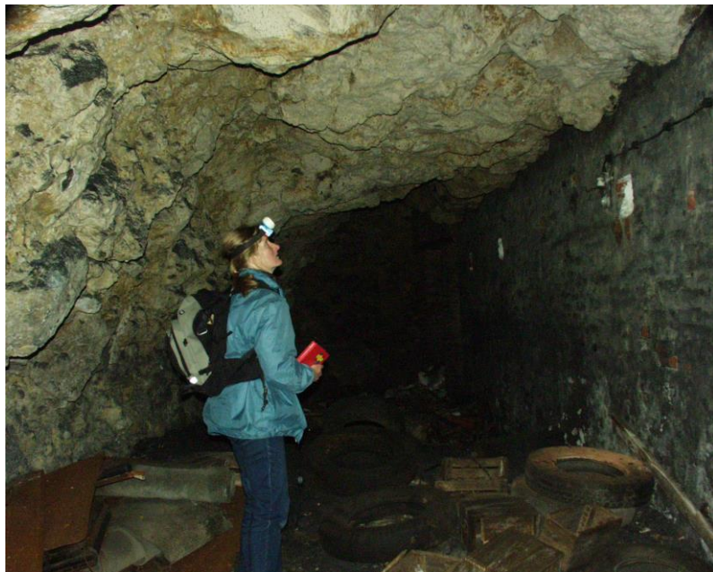
Rys. 2.1. Wnętrze lodowni, część przeznaczona na skład lodu Fig. 2.1. The inside of ice-cellar, place for store of ice
