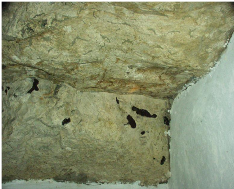
Rys. 2.1. Strop i ocios wyrobiska (na jasnych wapieniach widoczne są czarne kongrecje krzemienne, o miąższości ok. 10 cm) oraz biały mur oddzielający komórki lodowni Fig. 2.1. Roof and side-wall of excavation (on light limestones black flint concretions of 10 cm thickness are show) and white wall seperated ice-cellar chambers
