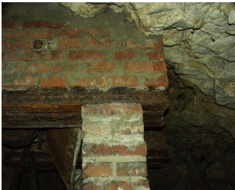
Rys. 2.1. Fragment obudowy szybu Fig. 2.1. Fragment of shaft casing
