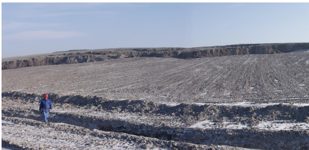
Rys. 5.1. Zerwa na poz.+453 po stronie zachodniej zwałowiska zewnętrznego Fig. 5.1. The fault on level +453 west side external dump
