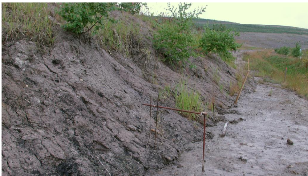
Rys. 4.3. Czoło deformacji po stronie wschodniej zwałowiska zewnętrznego BOT KWB Turów S.A.
