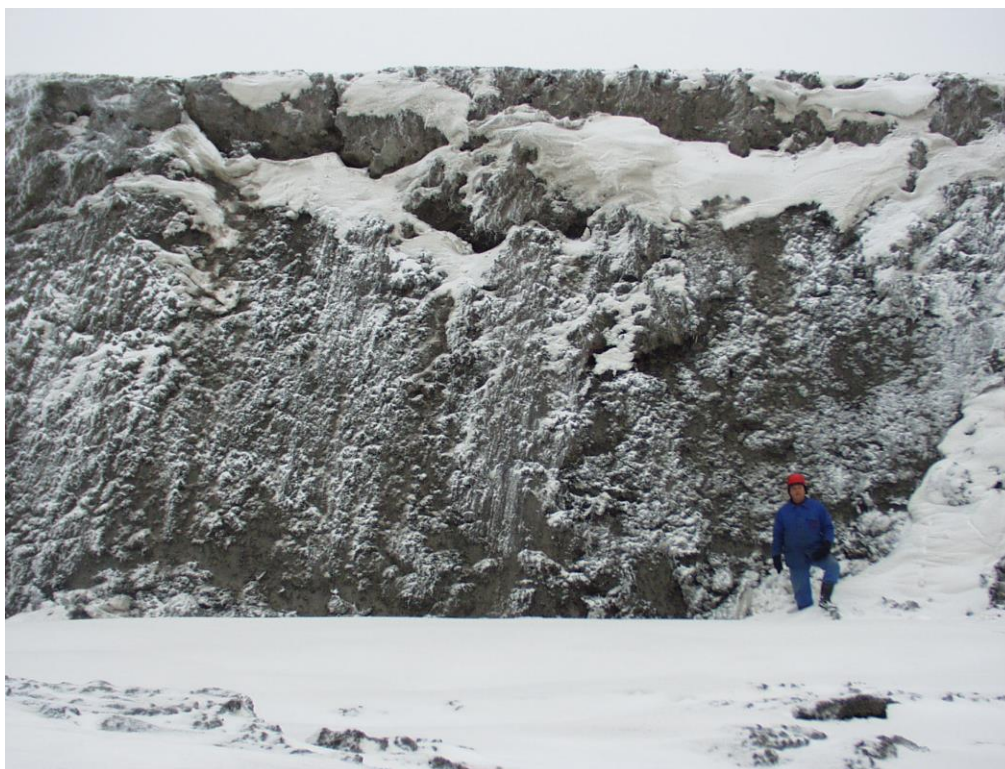
Rys. 5.2. Zerwa (ok. 8 m) na poz. +453 po stronie zachodniej zwałowiska zewnętrznego Fig. 5.2. The fault (8 m high) on level +453 on west side of the external dump
