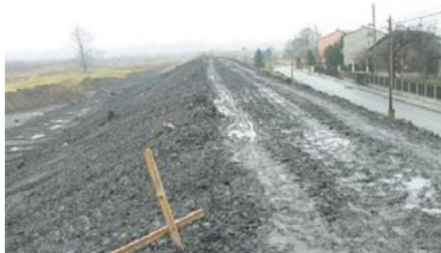
Rys. 7.2. Budowa wału przeciwpowodziowego w miejscowości Gromiec na rzece Wiśle z wykorzystaniem skały pónnej pochodzącej z ZG „Janina” w Libiążu
