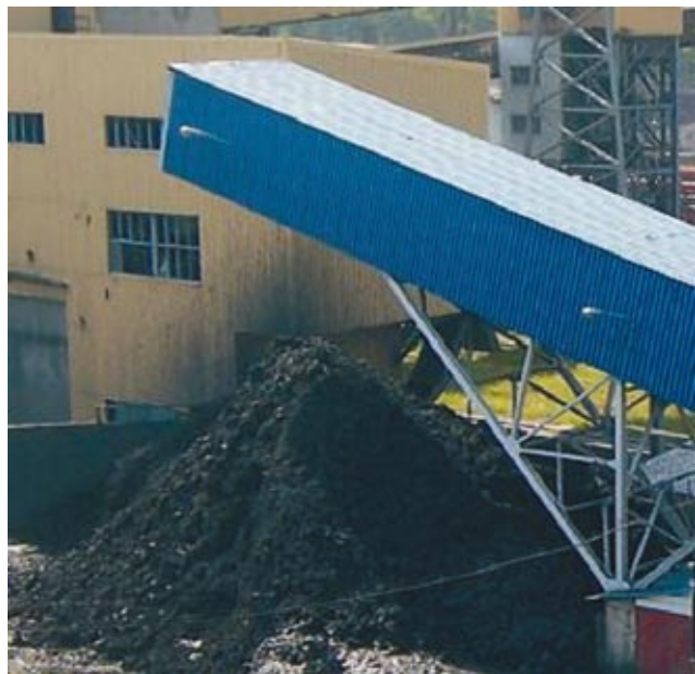
Rys. 6.3. Muły w postaci placków w miejscu załadunku na samochody dla elektrowni PKE S.A.
