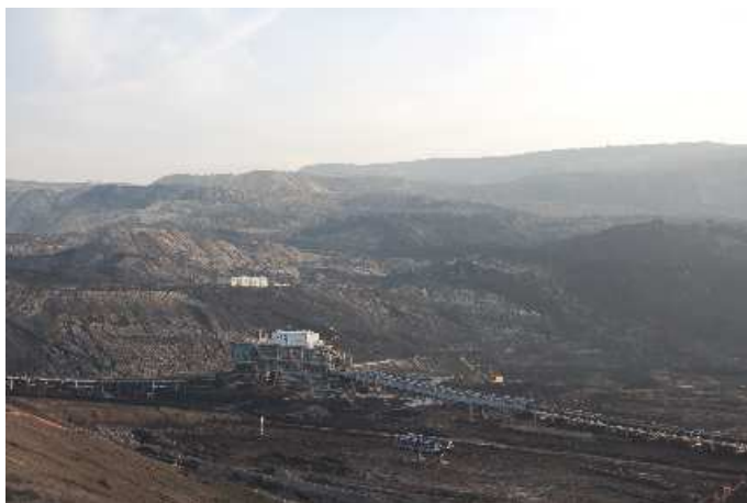
Rys. 1.1. Osuwisko 22S na zboczu południowym odkrywki w KWB Bełchatów
