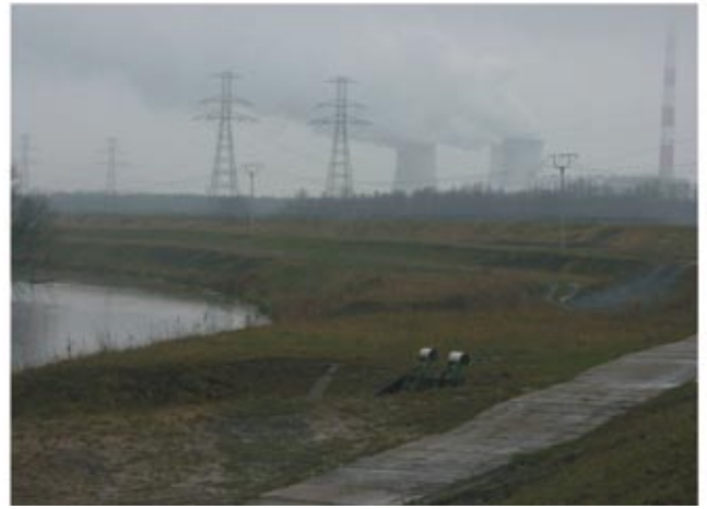
Rys. 9. Rzeka Przemsza - wały przeciwpowodziowe
