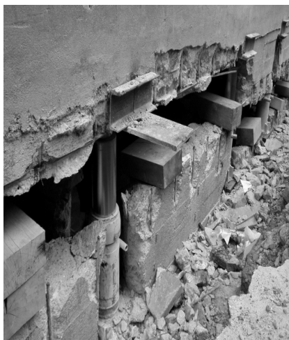
Rys. 6.1. Rektyfikacja obiektów za pomocą siłowników Fig. 6.1. Rectification with the help of boosters
