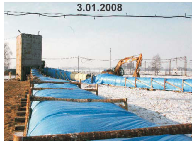
Rys. 5.1. Tymczasowe kanały wentylacyjne z lutni elastycznych ssących \varnothing 1000 oraz \varnothing 1200 mm
