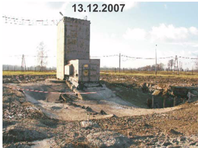
Rys. 1.2. Deformacje nieciągłe przy szybie V (stan na 13.12.2007 r.) Fig. 1.2. Non-continuous deformations within the ventilation shaft no. V (state for 2008.12.13)
